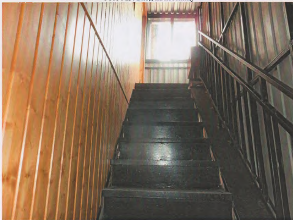
Фото №4. Состояние лестницы
