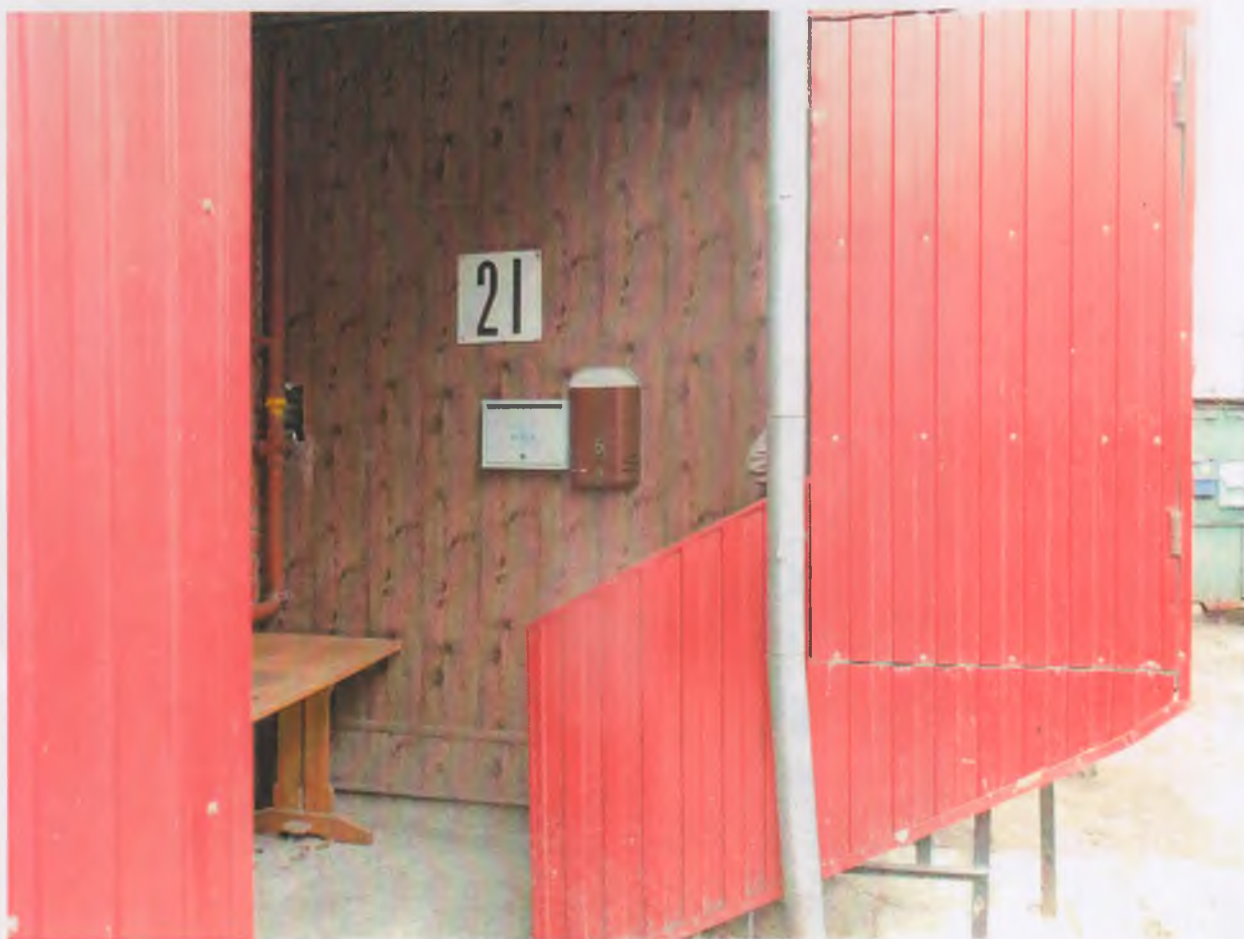
Фото №3. Вход на лестницу
